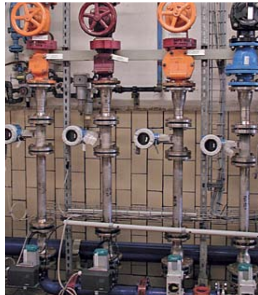
Prowirl monitorea los flujos volumétricos de agua completamente desalinizada
