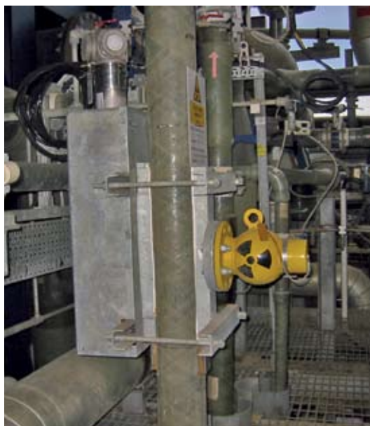
El Gammapiot instalado por lo general en el ciclo de absorción
