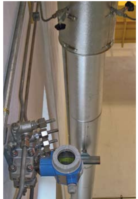
Deltatop (Deltabar S con elemento primario) para medir vapor sobrecalentado
