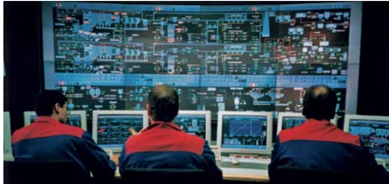
Sala de control de una central eléctrica moderna
