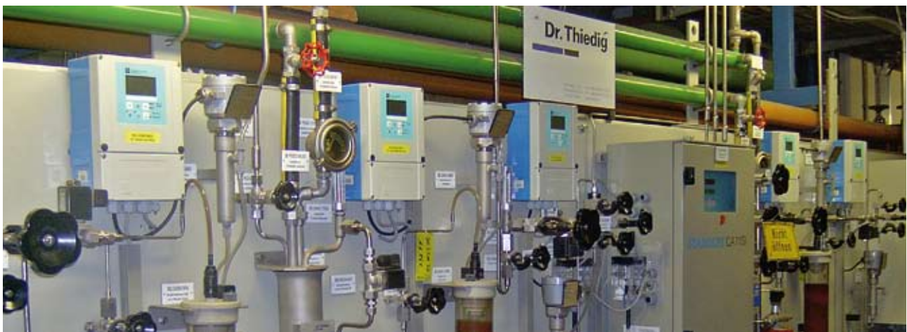
Sistema de muestreo con pH, conductividad y sílice
