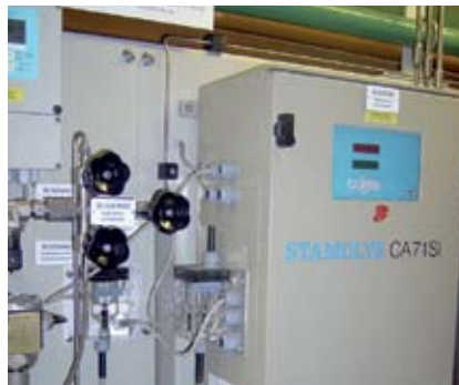
Stamolys para el control de silice para proteger la turbina
