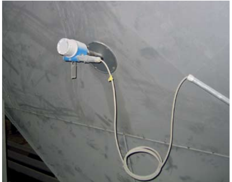
Sensor capacitivo para detección de límite máximo en el filtro electrostático
