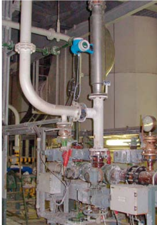
Promass instalado por lo general en el ciclo de absorción
