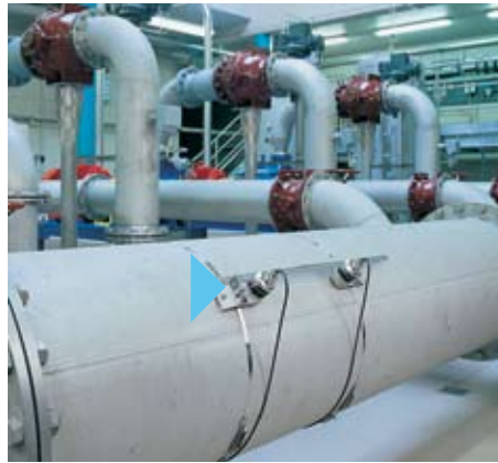
PROline Prosonic Flow se utiliza para controlar el agua de enfriamiento al condensador principal
