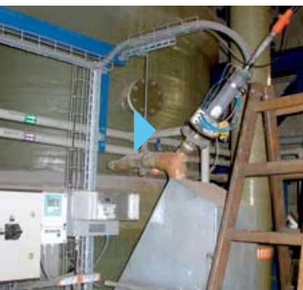
La armadura de proceso retráctil se instala directamente en la línea de suspensión de yeso asegurando una operación fiable de la medición de pH
