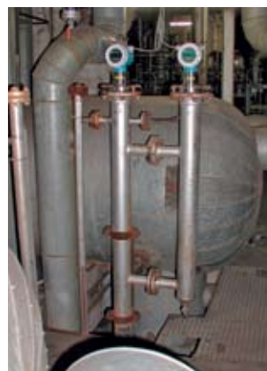
Precalentador de presión baja
