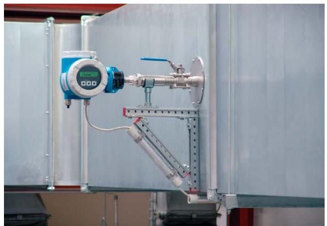
El principio de medición por dispersión térmica se utiliza ampliamente en la industria por su eficacia en muchas aplicaciones con flujos de gas, por ejemplo:
